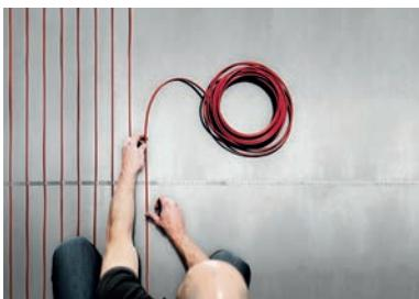
Шаг укладки нагревательного кабеля — расстояние между его линиями. Для системы «Теплый пол» при увеличении расстояния между линиями кабеля на поверхности пола могут появиться холодные зоны («тепловая зебра»)!
