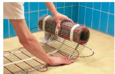
2. Так как диаметр трубы гораздо больше, чем толщина нагревательного мата, необходимо сделать штробу в полу и, если необходимо, в стене до монтажной коробки. Нельзя перегибать трубку и необходимо поставить заглушку со стороны датчика в полу, чтобы избежать попадания клея в трубку.
